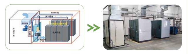
自主對各廠空壓機運行能效比檢測,制定改善方案並實施完成,主要改善措施:①檢視供氣壓損;②減少 終端耗損;③夏季機房溫度優化;④漏點檢測等。2021年已完成21家工廠共計83台空壓機檢測及改善,節 省用電量共約1,231兆瓦時;減少二氧化碳排放量757噸。
