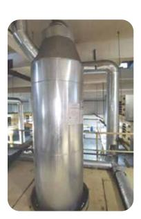
結合跨行業纏繞式換熱技術,導入食品螺旋管式換熱器,提高換熱效能,節省蒸汽用量。該技術2021年在 成都、瀋陽工廠導入應用,節省蒸汽用量共約550噸;減少二氧化碳排放量163噸。
