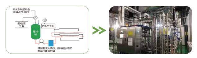
通過自主設計及實施,將廠內冷凝水集中收集,對熱水系統升溫及殺菌機預熱,節省蒸汽用量。該技術 2021年11月在廣州工廠完成改造,2022年規劃在成都、長沙工廠實施,預估年節省蒸汽用量2,800噸; 年減少二氧化碳排放量830噸。
