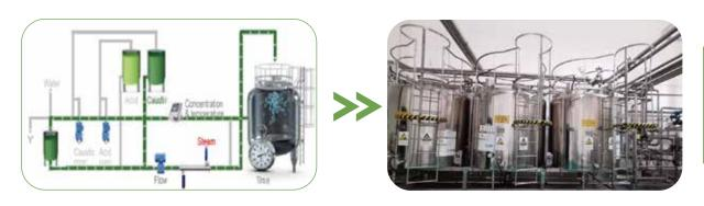
通過自主優化及食品安全相關驗證,在確保產線清洗效果的前提下,將CIP(Clean In Place 縮寫,指自動設備或管道內部線上清洗)清洗水溫度優化,節省蒸汽用量。2021年1-3月在陝西、杭州、南寧**3**家工廠完成測試驗證,4月起正式導入,節省蒸汽用量共約**1,161**噸;減少二氧化碳排放量**344**噸。
