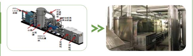
回收蒸箱二次蒸汽,運用蒸汽純化增壓技術,即熱能轉換及蒸汽壓縮後將回收的蒸汽供給蒸箱使用,節省蒸汽用量。該技術2021年已在武漢工廠導入應用,節省蒸汽用量共約**1,362**噸;減少二氧化碳排放量**404**噸。
